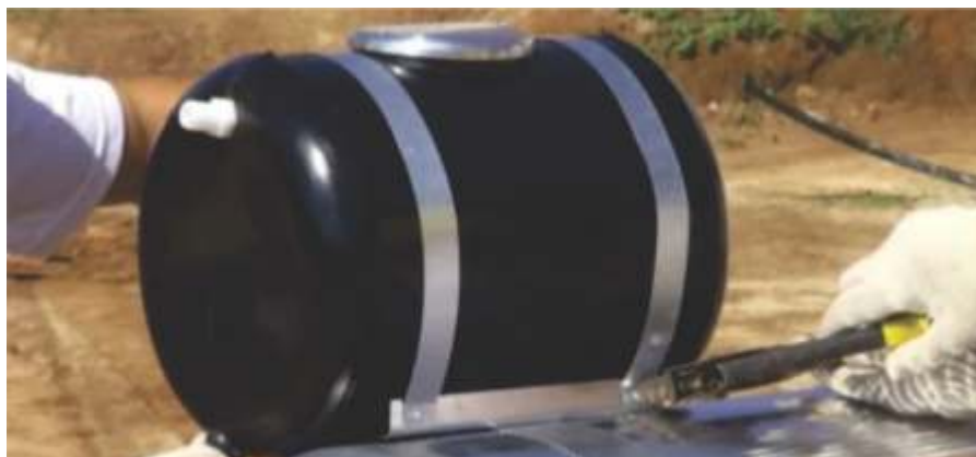
Caixa Quebra-Pressão sendo fixada com rebites
