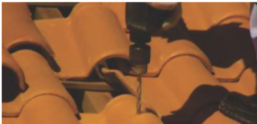
Furo sendo feito em telhado tipo capa
