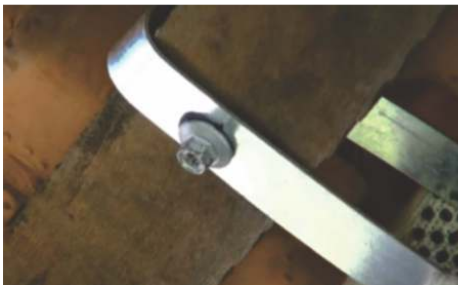
Suporte tipo cinta metálica para coletores fixado na estrutura do telhado
