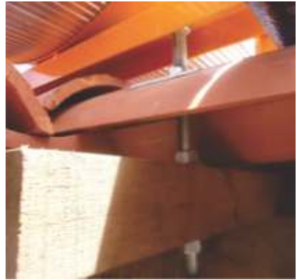
Vista em corte da barra roscada instalada
