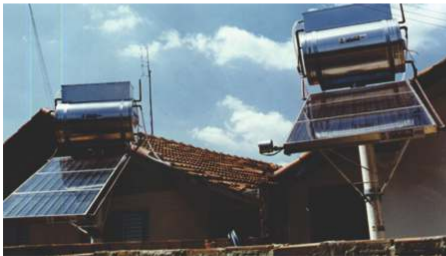
Aquecedores Solares POPSOL na COHAB de São Manuel - SP
