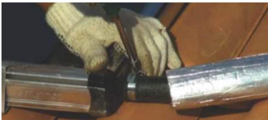
Isolamento térmico é afastado para fixação da abraçadeira junto ao coletor solar
