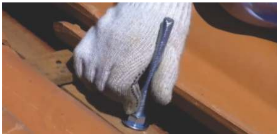
Fixação da barra roscada no caibro auxiliar
