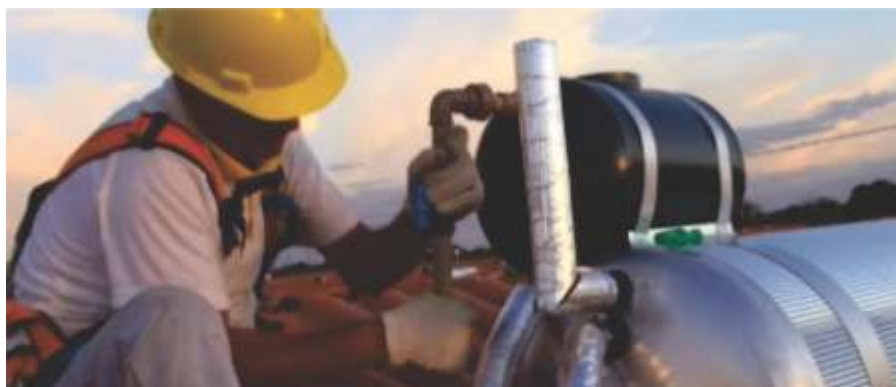
Rede hidráulica de água fria sendo conectada à Caixa de Quebra-Pressão e Respiro isolado termicamente
