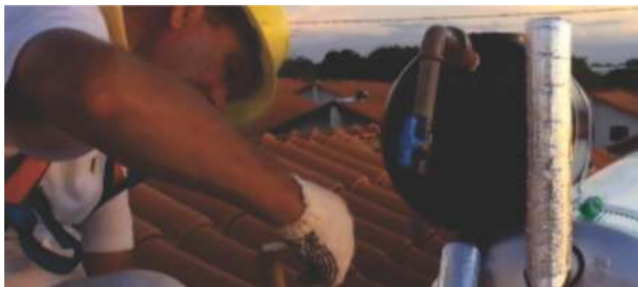
Registro de PVC sendo instalado na Caixa de Quebra-Pressão
