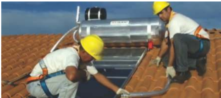
Mangueira sendo fixada no coletor solar
