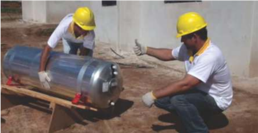
Montagem da Caixa de Quebra-Pressão no RT sobre gabarito
