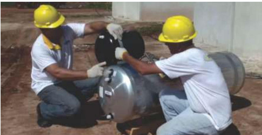
Caixa de Quebra-Pressão sendo fixada no RT com uso de gabarito
