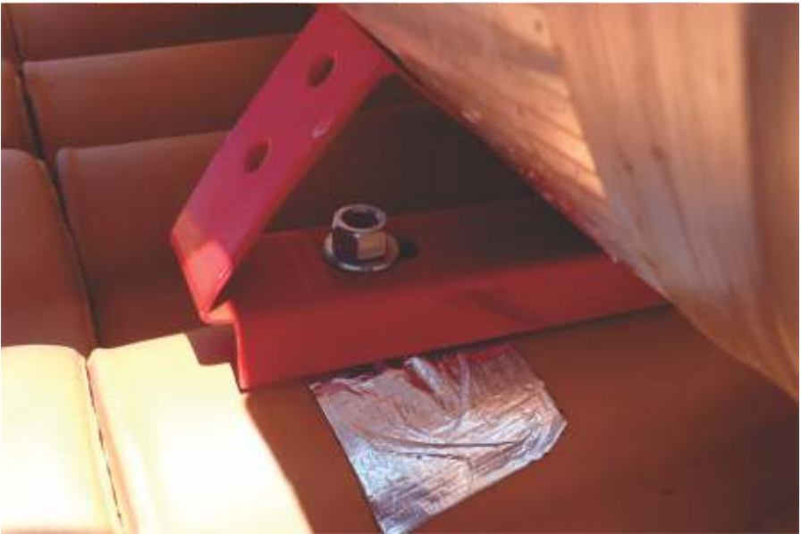
Porcas e pés do reservatório térmico já sendo fixados nas barras roscadas
