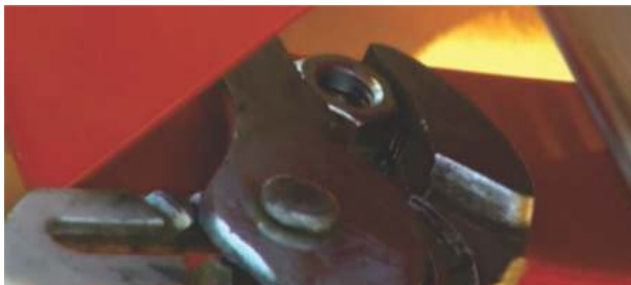
Porca de fixação do reservatório térmico na barra roscada sendo apertada
