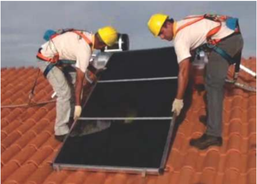
Aquecedor Solar compacto sendo instalado
