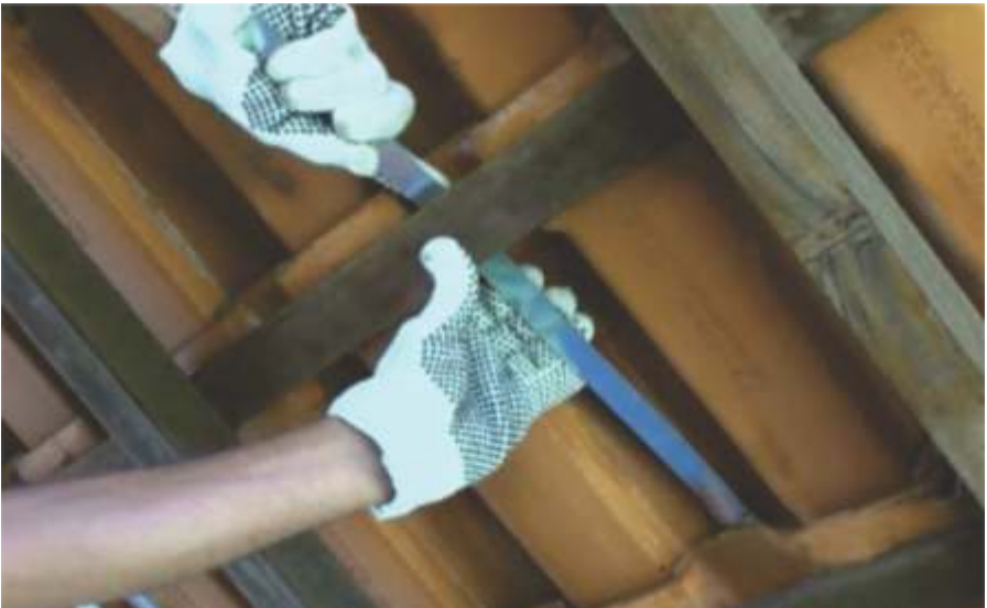
Passo 1 da fixação da cinta na estrutura do telhado
