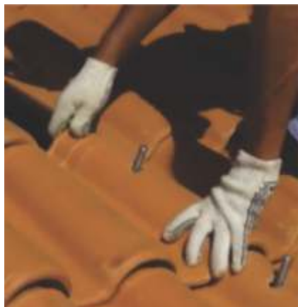
Telha furada sendo colocada sobre a barra roscada já fixada
