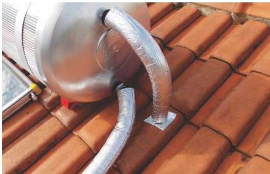
Tubo Hidráulico vedado com silicone e manta asfáltica
