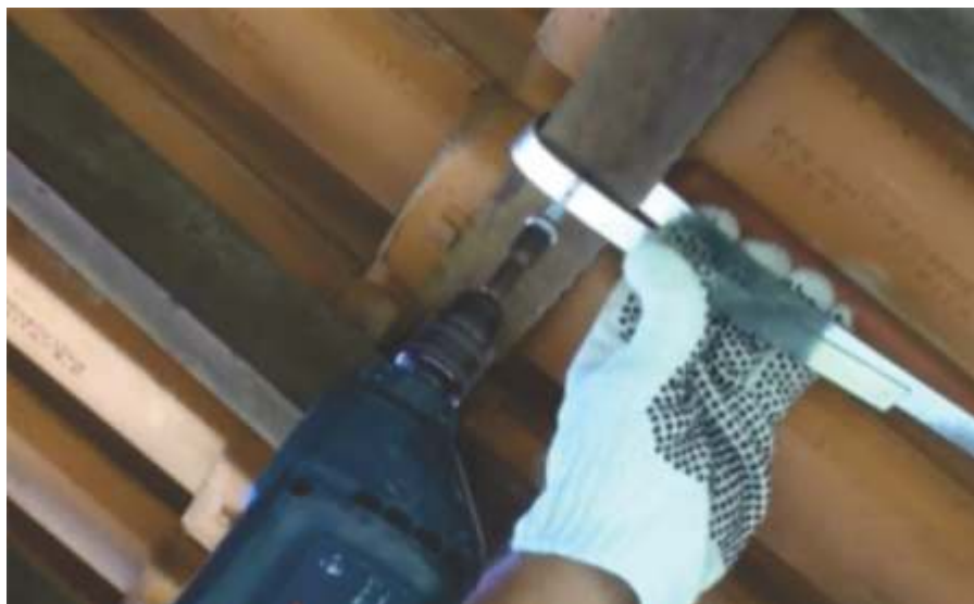
Passo 2 da fixação da cinta na estrutura do telhado
