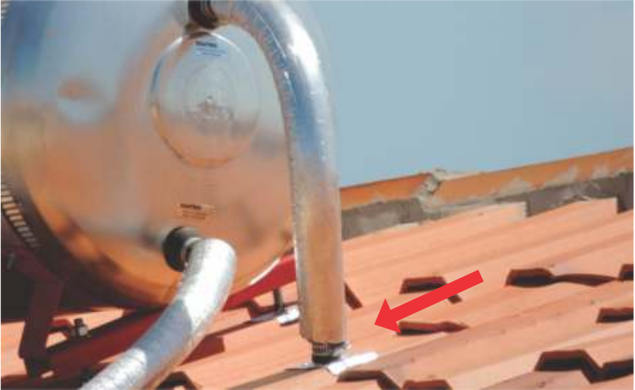
Interligação do tubo de consumo do reservatório térmico na hidráulica da residência
