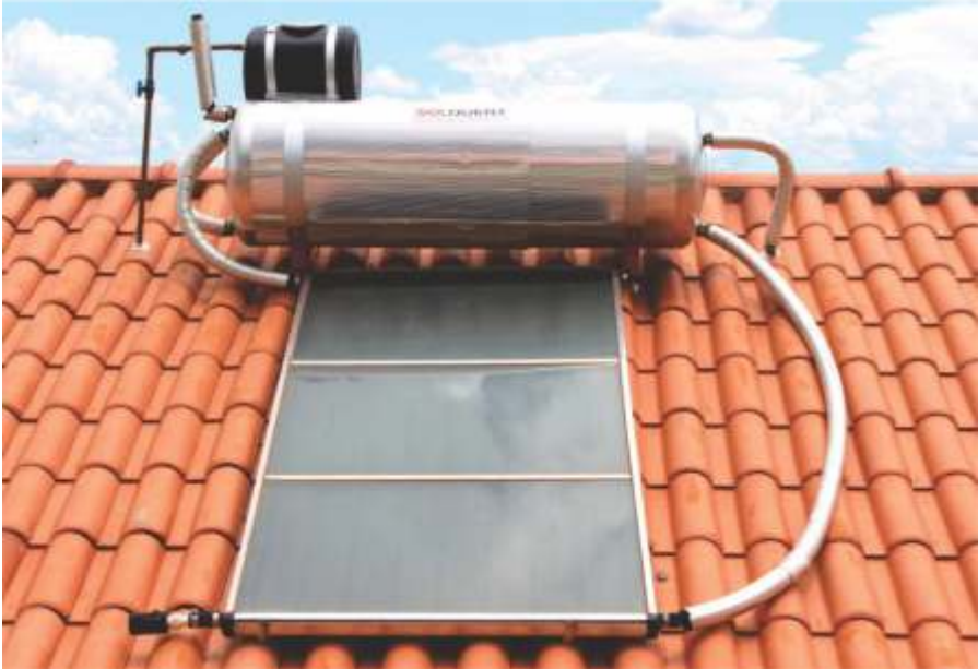
Aquecedor Solar Compacto com sua instalação concluída e pronto para aquecer a água e gerar benefícios
